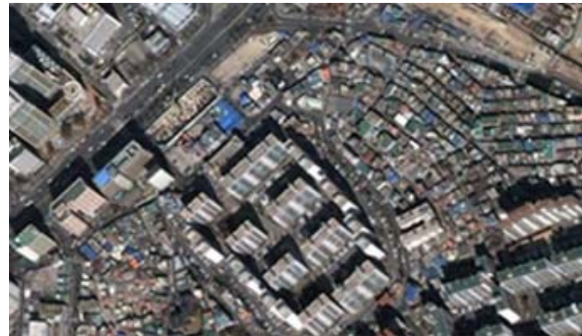
Fig. 21 : Vue aérienne, Tanji de Samsung (source : Google Earth)
