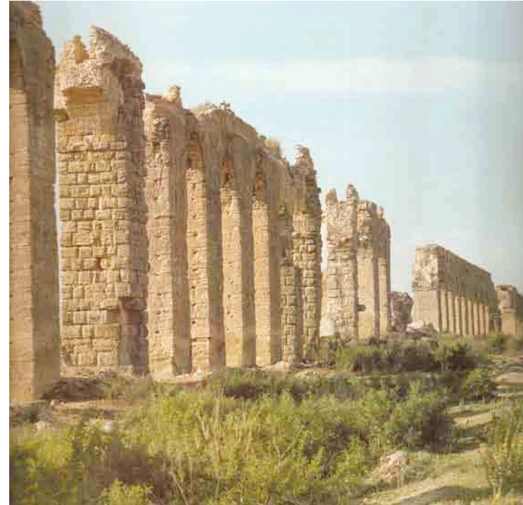
Figure 15 : L'aqueduc de Zaghuan , Tunisie, œuvre de génie civil impressionnante élevée sous le règne d'Hadrien, pour apporter l'eau à Carthage qui est alors la capitale de l'Afrique proconsulaire. Il fournissait l'eau pour desservir 300 000 habitants.
